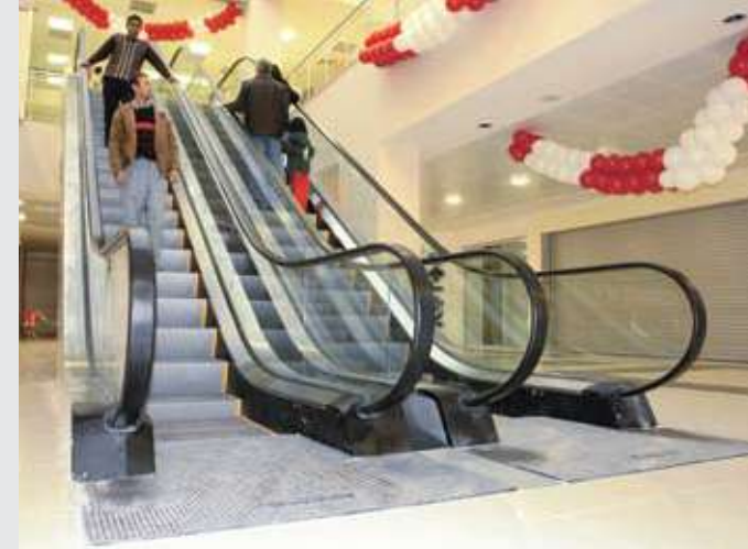
Yer : Karum AVM Uşak Yapıldığı Tarih : 2006 Teknik özellikleri : Yükseklik : 4200 mm. Açı : 35 Basamak genişliği : 800 mm.
